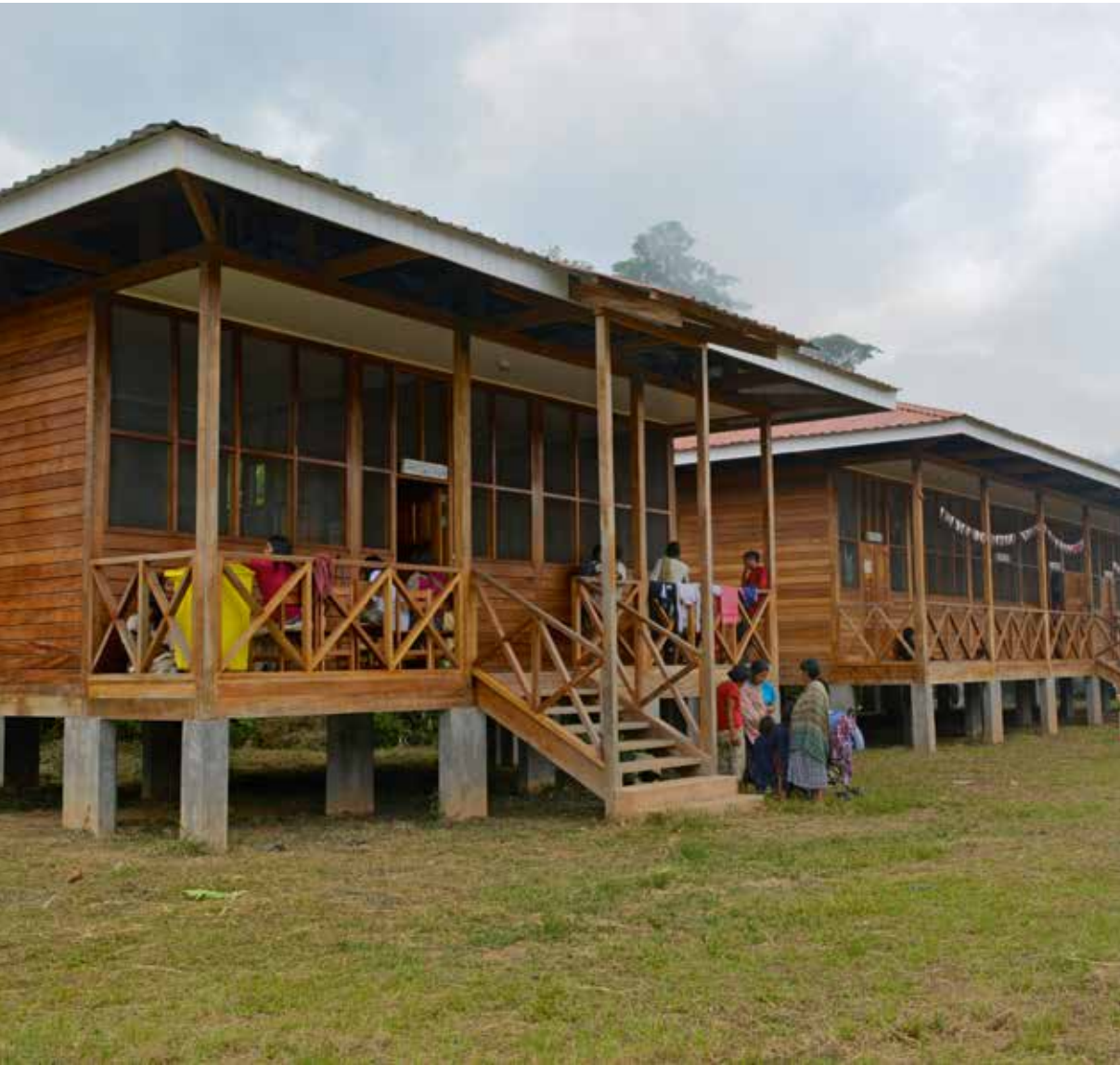
Nueva infraestructura de la escuela en Yomibato (2018). ©Karol Mejía / FZS Perú
